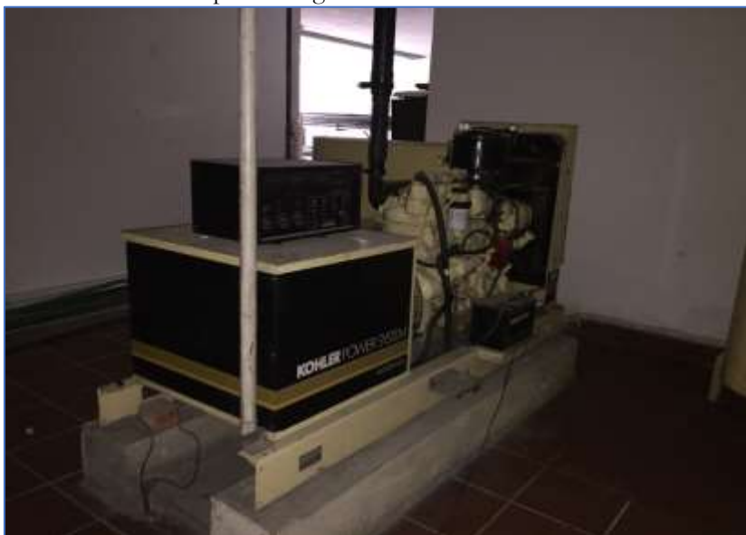
Ilustración 7: planta de generación eléctrica sede 1 FDLCH.
