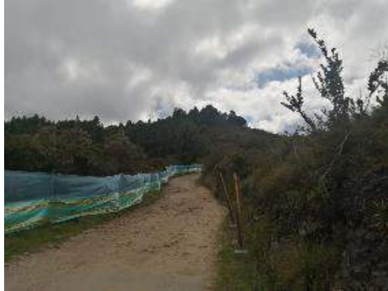
Registro actual Obras en ejecución: Contratos 304 y 308 de 2021.
