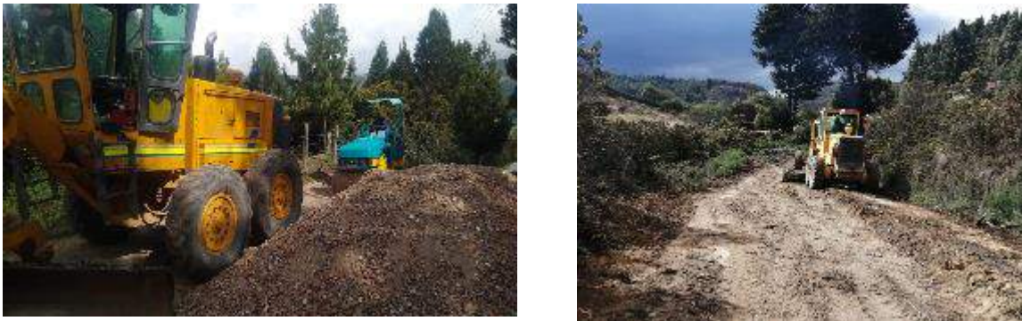
Registro actual Obras en ejecución: Contratos 304 y 308 de 2021.
