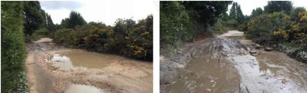
Registro antes de intervención: 2003155 - 2003156 – 2002517.
