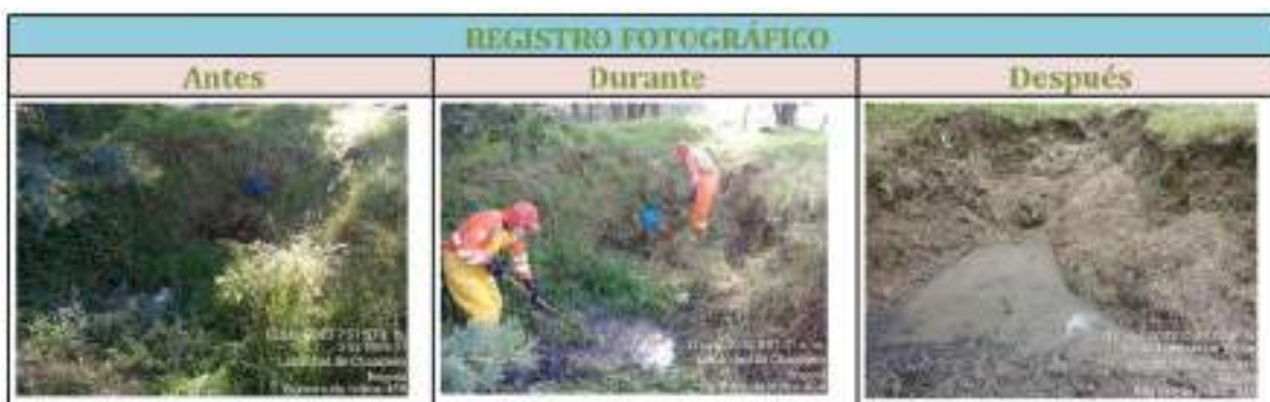
Figura 25 Registro fotográfico resultados Canal Cataluña
