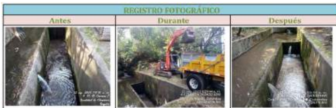
Figura 28 Registro fotográfico Desarenador Quebrada Chicó
