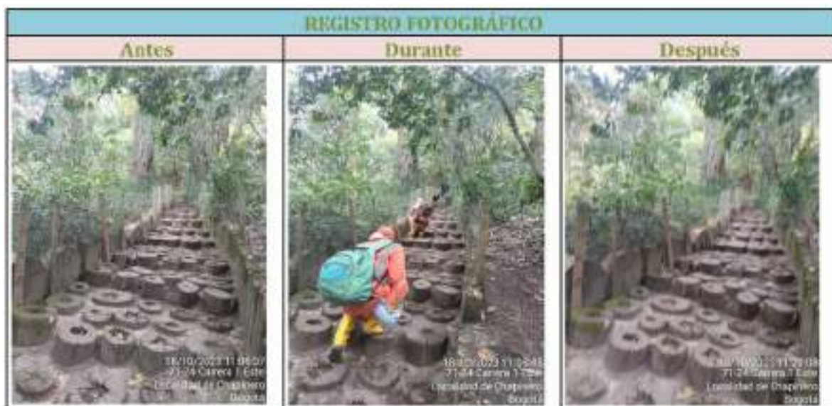
Figura 30 Registro fotográfico Desarenador Quebrada La Vieja
